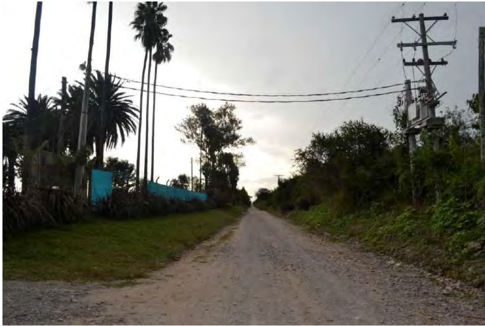
Vista actual de la Ruta Prov. N°87
